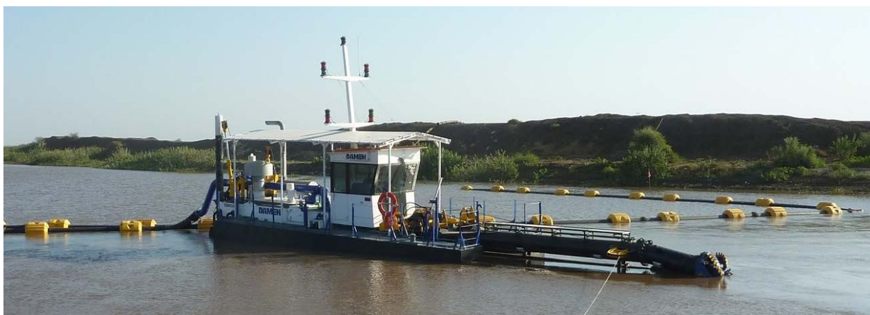
Figur 5-1: Cuttersuger monteret på flåde med pumpestation og jordspyd for fastholdelse under arbejdet
